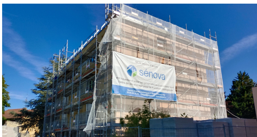
COPROPRIÉTÉ LES DEUX PONTS EN COURS DE TRAVAUX – RÉCEPTIONNÉ EN JUILLET 2023
